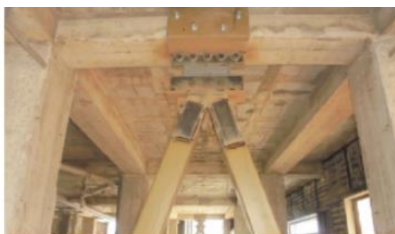
Figura 2. 24. Instalación de dispositivo SLB para la rehabilitación sísmica del hotel Ceibo Dorado tras el terremoto de octubre de 2016 en Ecuador. (Nuzzo et al., 2018)
