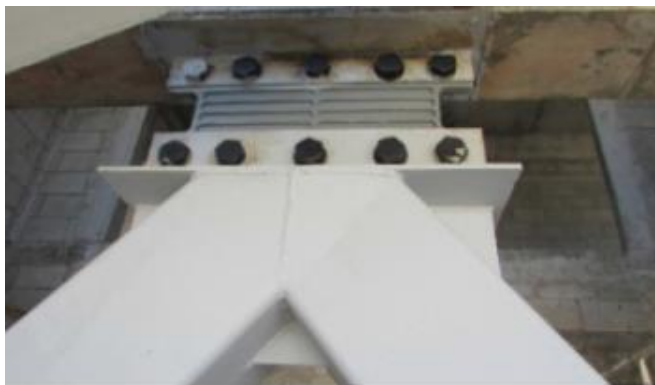
Figura 2. 23. Instalación de dispositivo SLB para nueva construcción de Torre Ixtapa (México) (Nuzzo et al., 2018)
