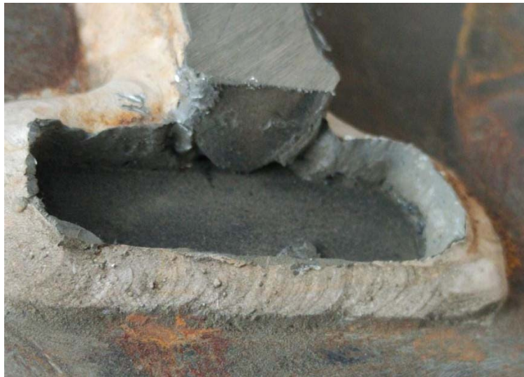
Figura 3.30. Detalle de la soldadura que falló durante el ensayo 3
