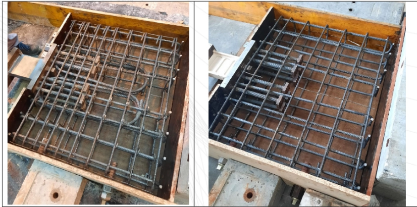
Figura 3. Detalle del armado de los disipadores 20208B-1,2 y 3 (izq.) y del disipador 20208B-4 (der.)
