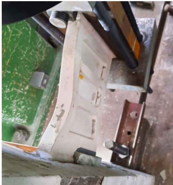
Figura 3.27. Estado del disipador al acabar el ensayo 1
