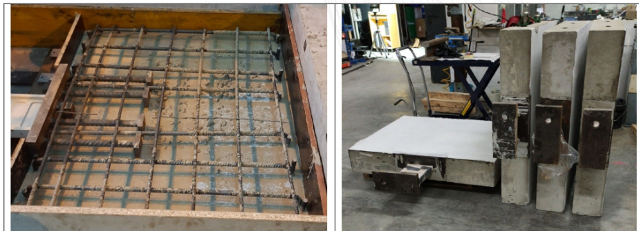
Figura 4. Aspecto del encofrado tras añadir la primera amasada de hormigón (izq.) y aspecto de los cuatro disipadores en los bloques de hormigón (der.).
