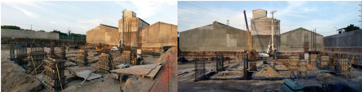
Fotografía 1 Estado de la obra a finales de julio del 2015 mostrando la planta sin muros excepto en el extremo donde están trabajando las máquinas de pilotes donde se ubican los muros de comunicación y cerramiento.
